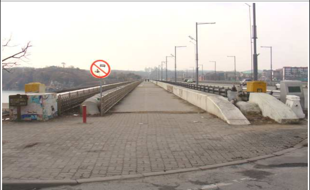
중점측 상부 전경
